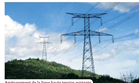
Aménagement de la ligne haute tension existante
