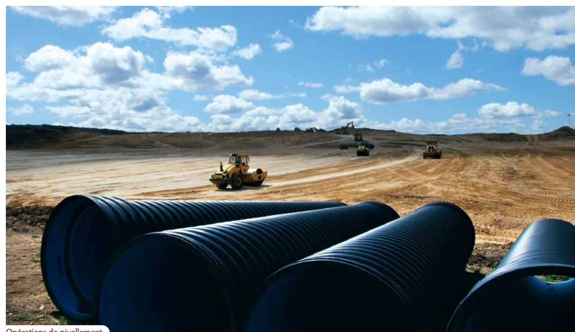
Opérations de nivellement
