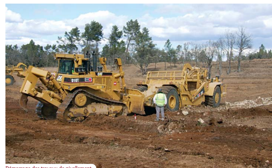
Démarrage des travaux de nivellement
