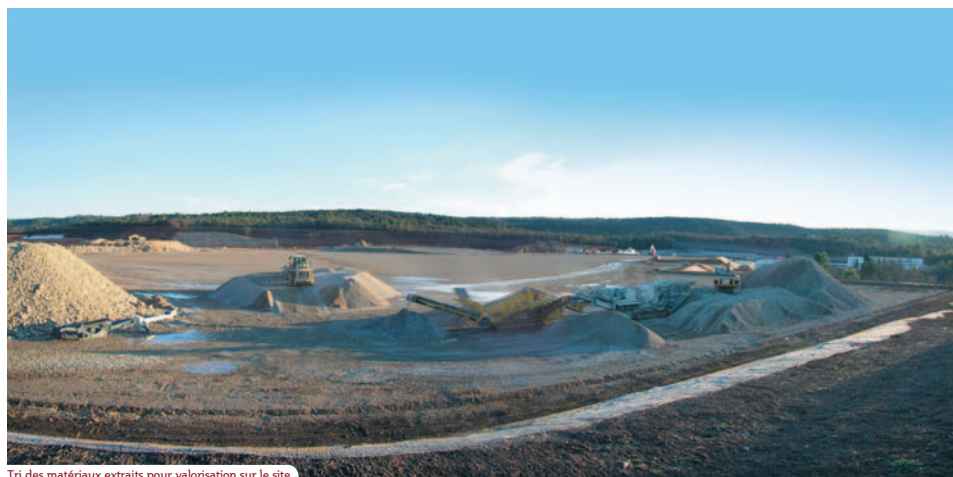
Tri des matériaux extraits pour valorisation sur le site
