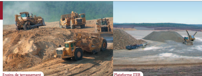
Engins de terrassement
