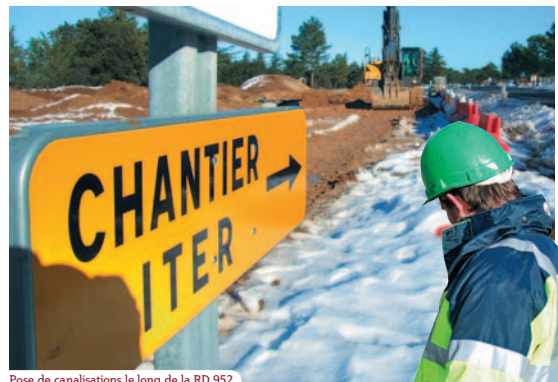
Pose de canalisations le long de la RD 952
